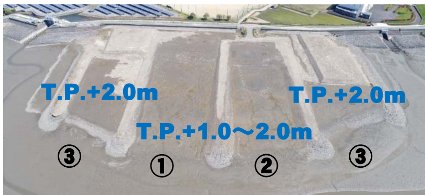
ブロック① T.P.+2.0mから先端のT.P.+1.0mまで緩勾配形状
