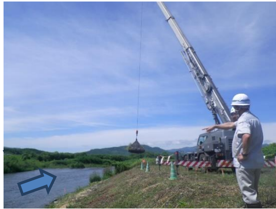
設置作業状況
