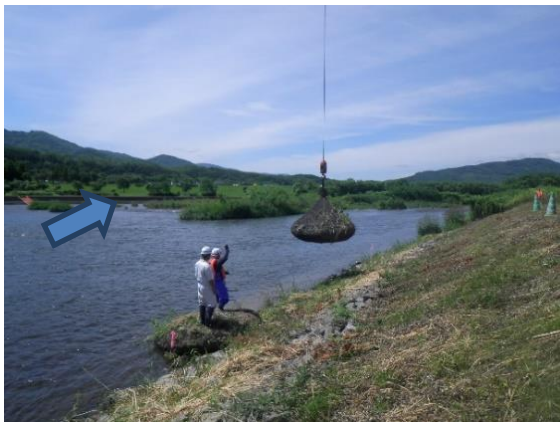
設置作業状況
