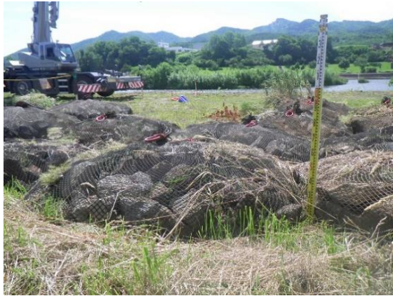
設置に使用した袋型根固工
