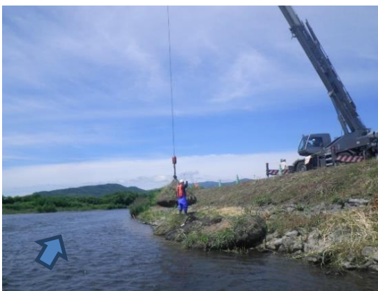
設置作業状況
