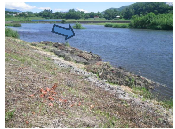
設置状況 下流から望む
