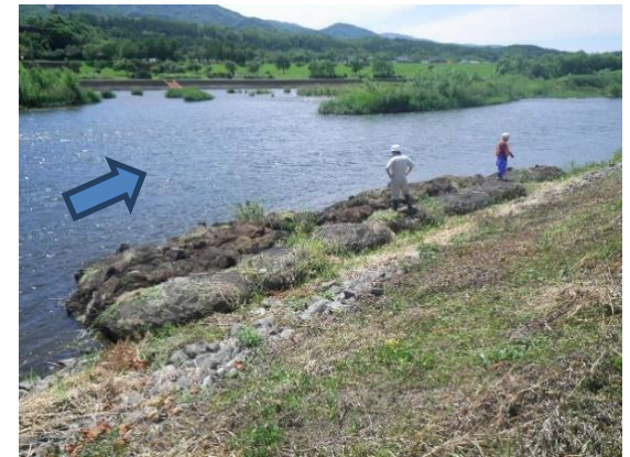
設置状況 上流から望む
