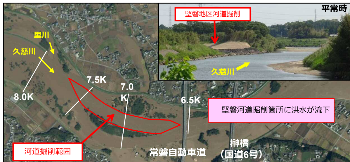
令和元年10月洪水時の堅磐河道掘削箇所の状況
