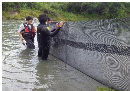
③ヤシ繊維マットに固定 ・又釘を用いて固定
