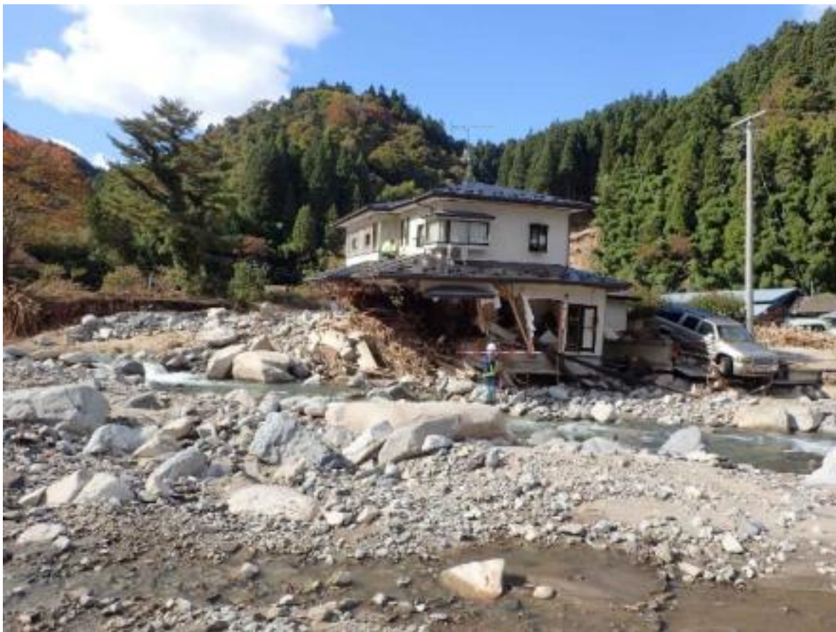
土石流により半壊した家屋(五福谷川)
