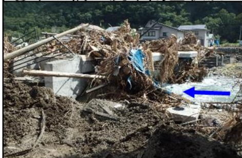
①中の橋の流木閉塞状況
