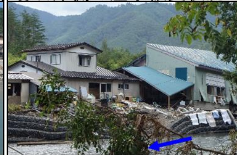
③右岸側の溢水被災状況
