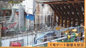
④ダム工区状況
