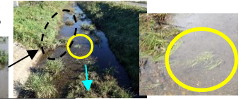
水制(バープエ)の設置
