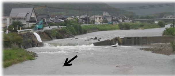
被災状況(落差工)
