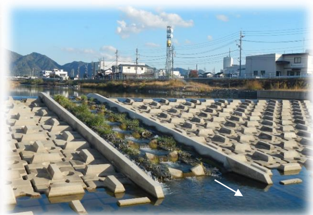
完成写真(R5.11月撮影)
