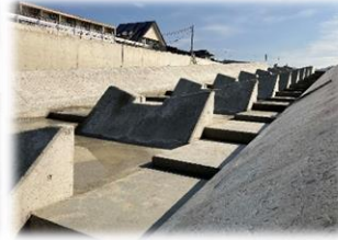
②エビ・カニ等が移動しやすいように、側面は緩傾斜とする
