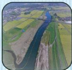
汚濁防止フェンス （羽月川 堂崎橋付近）
