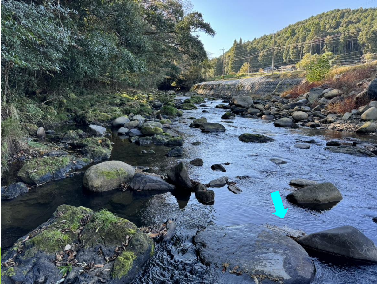
《施工箇所より直上流》
