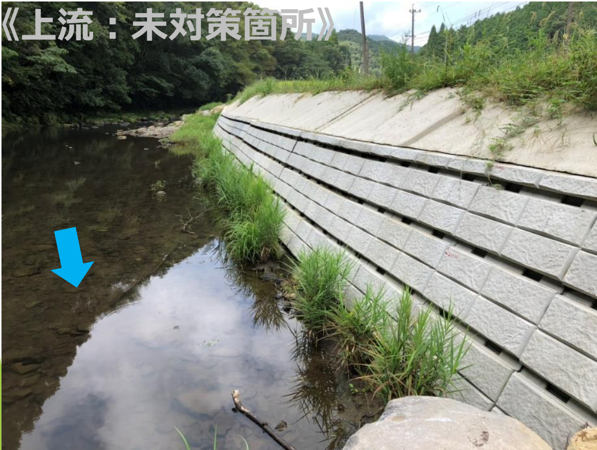
《下流：対策箇所（寄土・置石）》
