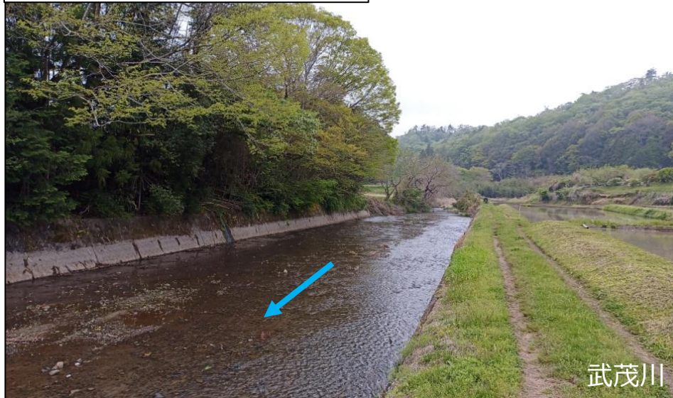
堆積土除去工事後の状況
