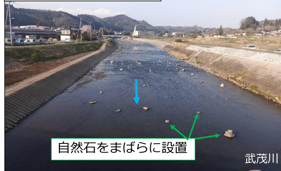
堆積土除去工事後の状況
