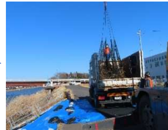
ラフタークレーンによる搬出作業
