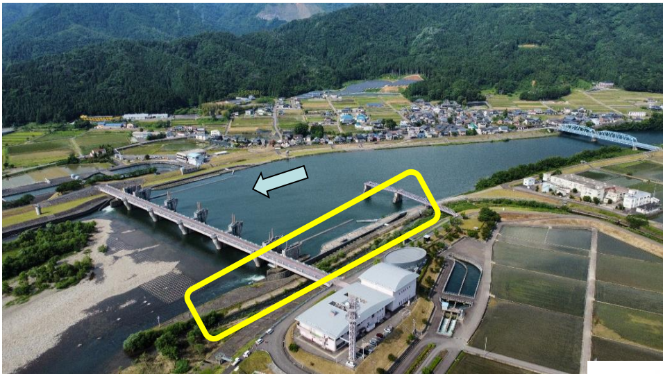
九頭竜川鳴鹿大堰(下流から上流を望む)
