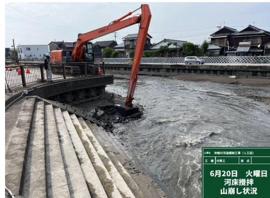
※水圧と攪拌により、ガタ土が浮遊し流れる
