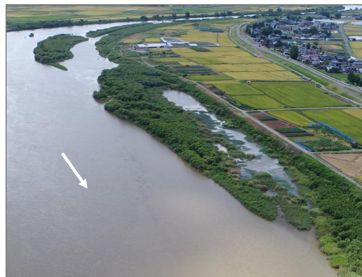
環境に配慮した河道掘削を実施した地区において形成された ワンド・湿地(令和元年9月12日撮影)
