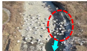
図3. 経年的な出水により移動した置石
