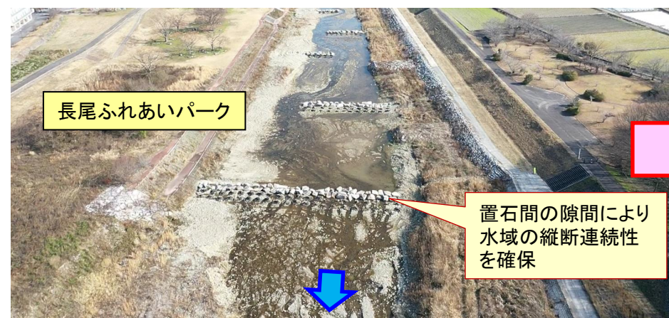
置石再配置施工直後（令和6年1月撮影）
