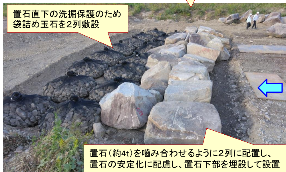
置石再配置施工状況（令和5年10月撮影）
