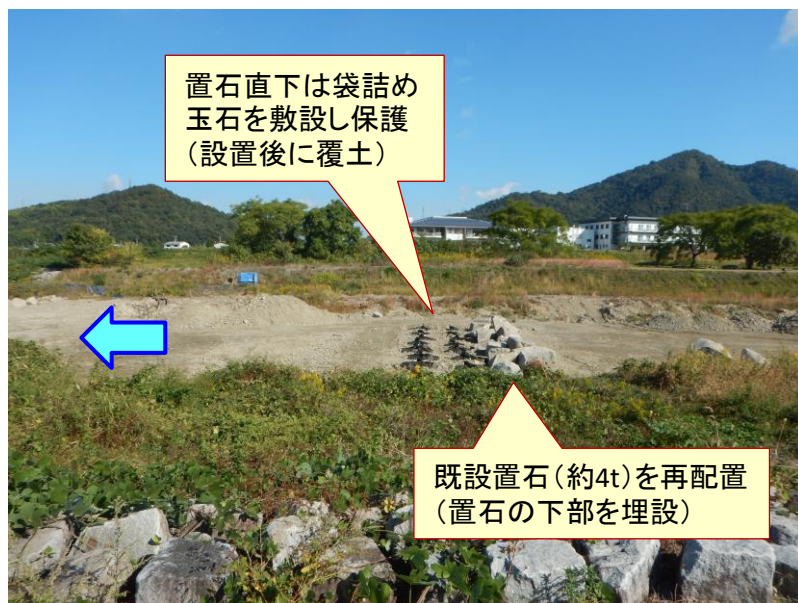
置石再配置施工状況（令和5年10月撮影）
