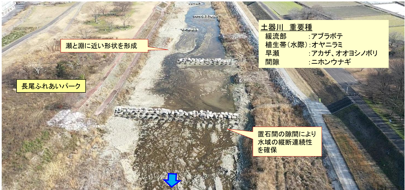
置石再配置施工直後(令和6年1月撮影)
