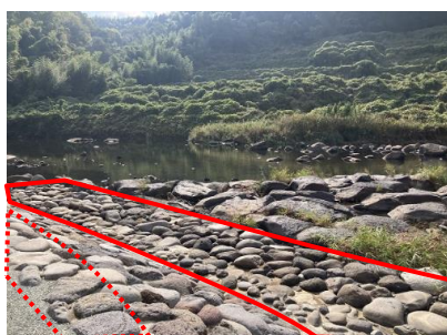
写真4 間詰工・肩止
