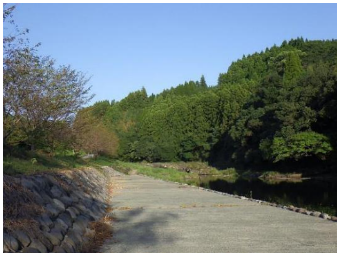
整備後の遊歩道
