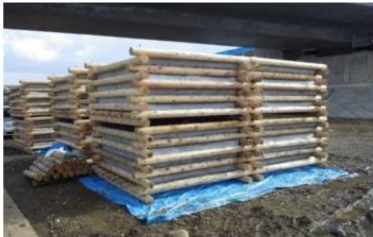
設置前の木工沈床
