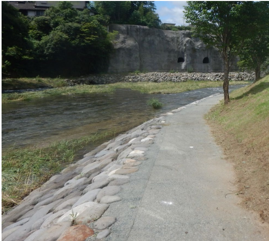
護岸整備の石積みにおいて、現地で発生した巨石を使用
