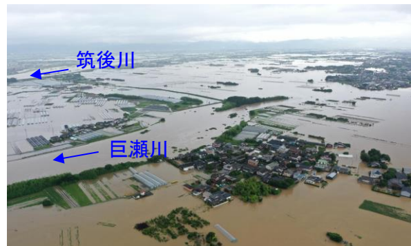
巨瀬川流域の浸水状況
