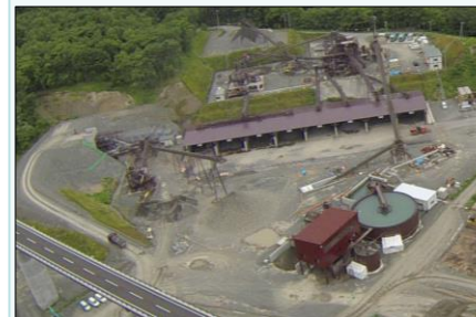
骨材製造設備
