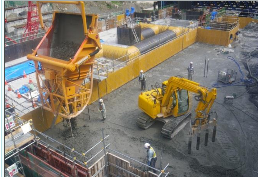
堤体打設状況
