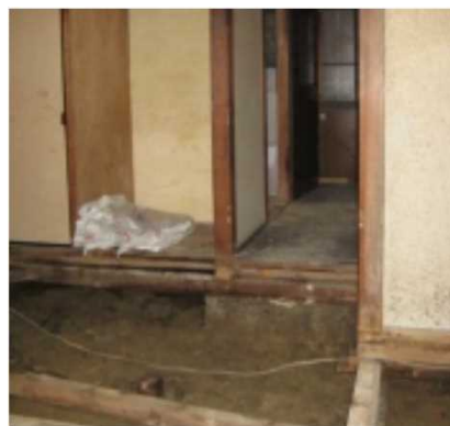
床下の土砂を排出する必要あり
