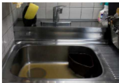
水が逆流し、水道が使えない
