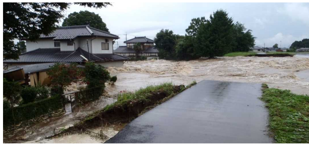
比高差が約4mだが、堤防決壊により家屋が流出(鬼怒川H27.9出水)
