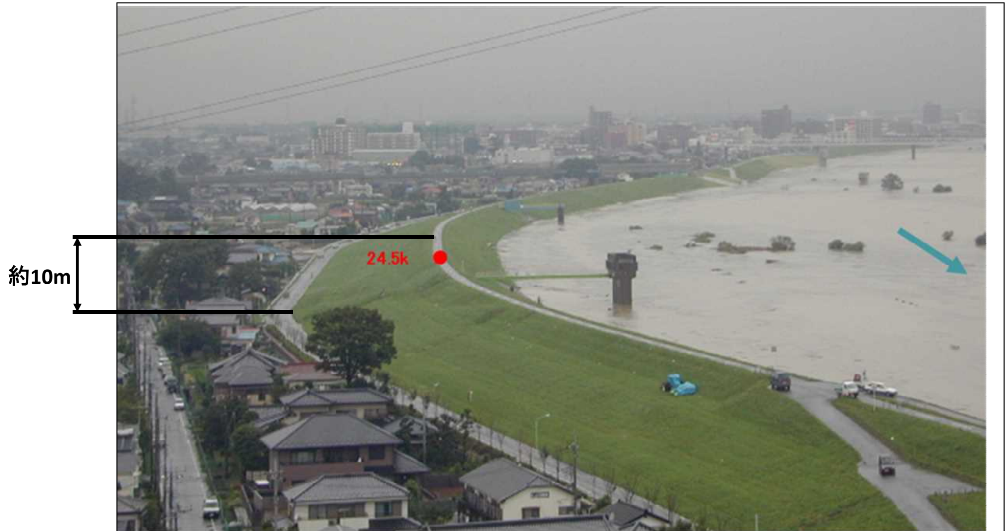
家屋の敷高より河川水位が数メートルも高くなっている状況(平成13年台風15号江戸川)
