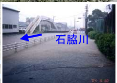
H16.6.30浸水状況
