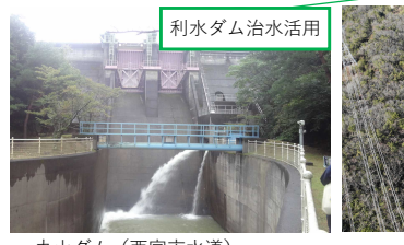
丸山ダム(西宮市水道) 通年水位低下35万m 3 (R2.7運用開始)
