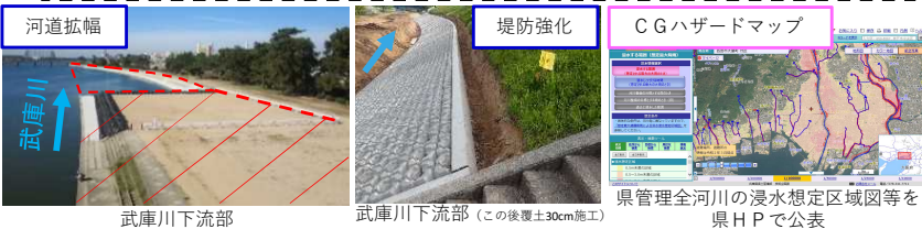
河道拡幅 武庫川下流部 堤防強化 武庫川下流部(この後埋土30cm施工) CGハザードマップ 県管理全河川の浸水想定区域図等を県HPで公表
