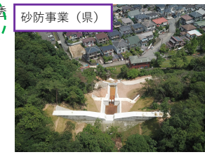
砂防事業(県) 高尾谷西堰堤(西宮市)等
