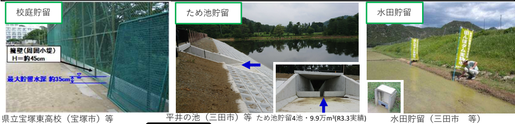
校庭貯留 校庭貯留11校・1.6万m 3 (R3.3実績) 平井の池(三田市)等 ため池貯留4池・9.9万m 3 (R3.3実績) 水田貯留(三田市等)
