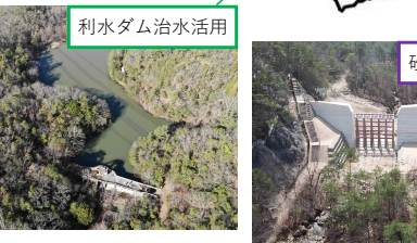
名塩ダム(西宮市水道) 通年水位低下5.8万m 3 (流域貯留浸透事業R3.6運用開始予定)
