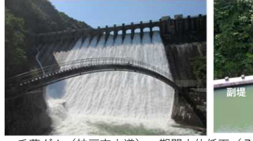
千刃ダム(神戸市水道) 期間水位低下(7~9月) 100万m 3 (県単独事業 R1.12工事着手 R4.6運用開始予定)
