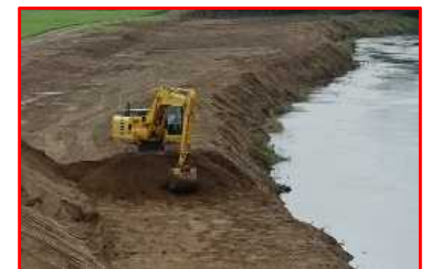
基幹産業を守る河道掘削（網走開発建設部、オホーツク総合振興局）
