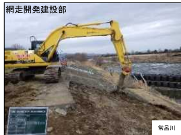
低水路護岸張替状況
