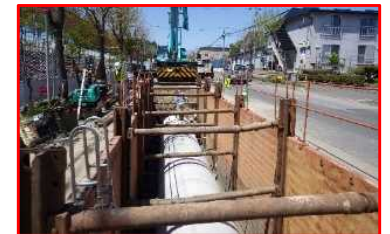
下水道雨水管の整備（北見市）
