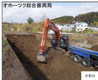
河道掘削状況
