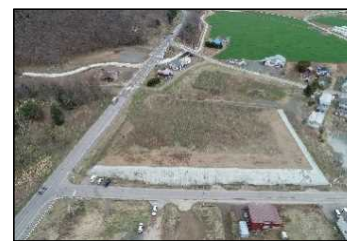
複合型公共施設の盛土造成状況
