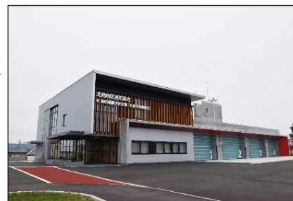
新消防庁舎外観
