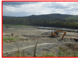
河道掘削(室蘭開発建設部)
