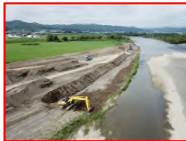
河道掘削（室蘭開発建設部）
