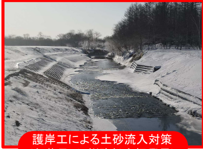
治山ダム設置による土砂の流出抑制 （弟子屈町内：根釧西部森林管理署）
