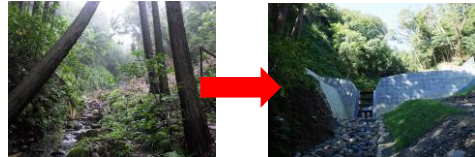
安居山沢右支川 砂防堰堤 (静岡県)
