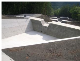
塩島沢堰堤群(富士川砂防事務所)
