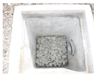
雨水貯留浸透枡整備事例(昭和田)
