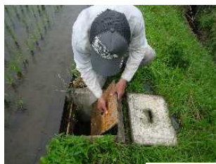
落水調整板の設置・更新
