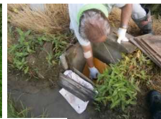
落水調整板の設置・更新
