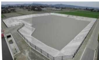
洪水調整池への流入(下流域溢水被害の未然防止)
