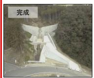
平成29年10月22日 の台風第21号に伴う 豪雨により土石流が 発生し長谷公民館等 が被災した多気郡多 気町長谷地内におい て、平成29年度から 整備を進めていた砂 防えん堤及び渓流保 全工が、令和4年1月 31日に完成。
