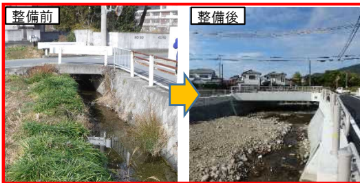
橋梁改築(山根川)(兵庫県)
