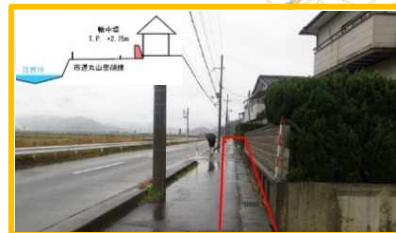
江古川地区の輪中堤整備(福井県)
