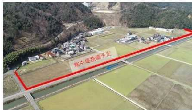
輪中堤整備（北川水系江古川）
