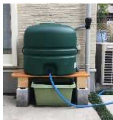
雨水タンク設置事例
