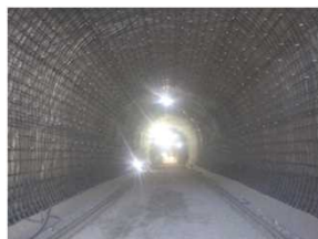
吐口側作業坑施工状況
