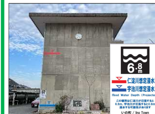
想定浸水深表示板を設置
