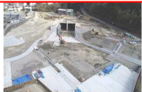
香口導水路施工状況
