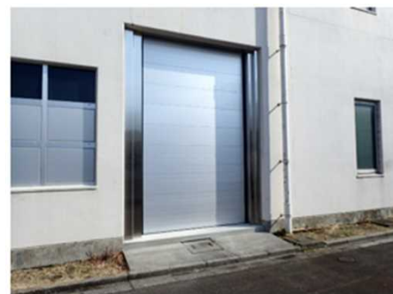
防水シャッターの設置
