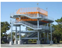
津波避難タワー
