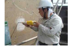
老朽化した施設の機能診断
