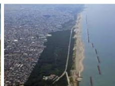
離岸堤の整備状況
