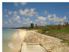
緩傾斜護岸の整備状況
