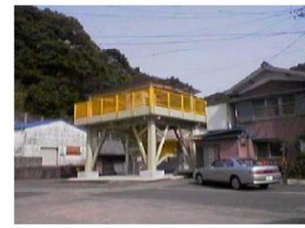
○避難タワーの設置
