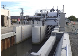
雨水ポンプ場の整備
