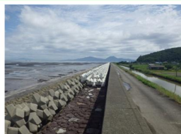
消波ブロック整備状況
