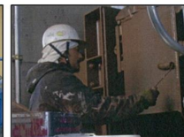
(ゲートの塗装)
