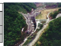
●噴山火山噴火に伴う火山泥流(土石流)に對する火山山砂防堰堤(新潟県魚沼市)
