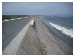
堤防整備状況
