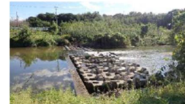
遡上阻害となっていた落差工の改善
