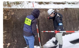
激甚災害後の治山施設の点検支援
