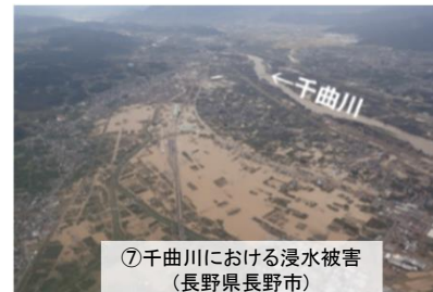
【令和元年東日本台風】
