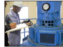
（ポンプの点検整備）
