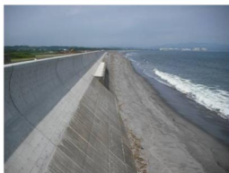
堤防整備状況
