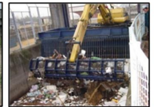
（水路の塵芥除去）
