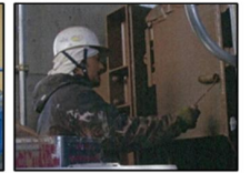
（ゲートの塗装）
