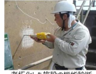
老朽化した施設の機能診断
