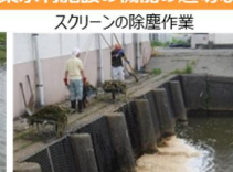
スクリーンの除塵作業
