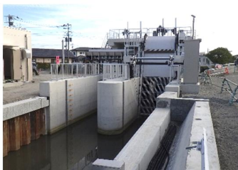
雨水ポンプ場の整備
