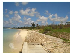
緩傾斜護岸の整備状況
