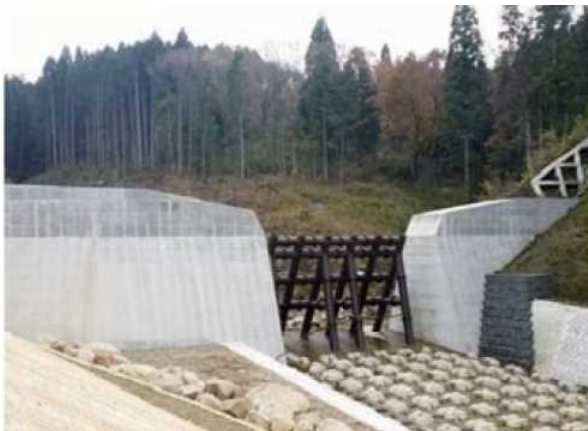
砂防関係施設整備
