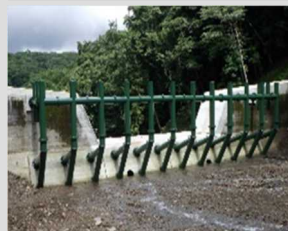
流木捕捉工の追加設置 (多機能化)
