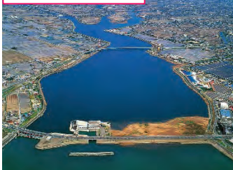
排水機場と周辺の市街地
