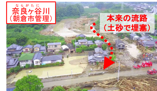
国が準用河川の災害復旧を代行することが想定される例 （平成29年九州北部豪雨（福岡県・筑後川水系））
