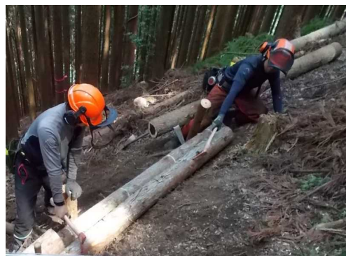
山地斜面における筋工の設置状況
