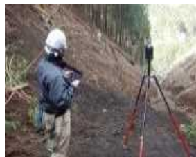
ICT施工の活用
