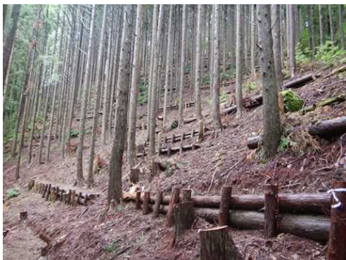
保安林の整備と雨水の浸透を促進する筋工の完成状況
