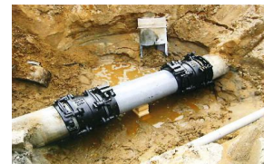
漏水防止のための整備
