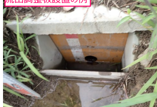
流出調整板設置の例
