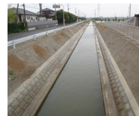
排水路の整備
