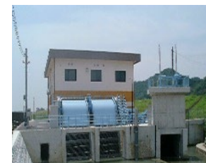
排水機場の整備
