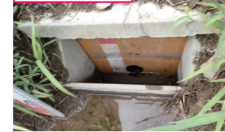
流出調整板設置の例
