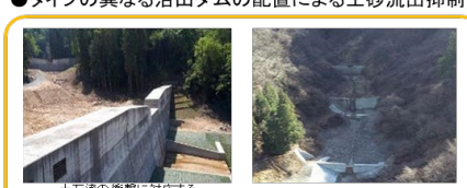
土石流の衝撃に対応する断面の厚い治山ダム 小規模な治山ダムを階段状に配置
